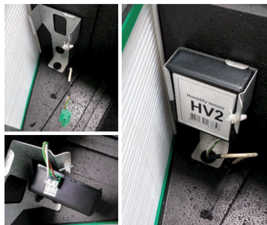
Installation de la sonde hygrométrique «Plug & Play» sur son support.
